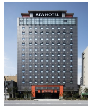
アパホテル浅草田原町駅前新築工事
