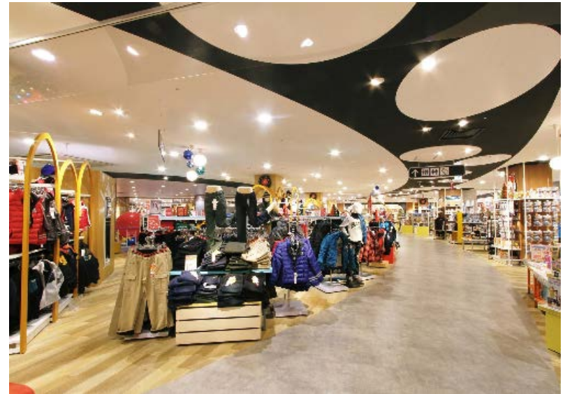
イオンスタイル板橋前野町店 <全館改修工事>
