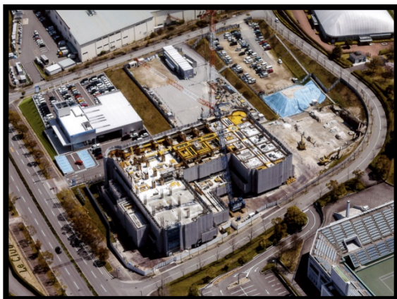
躯体工事 (柱・梁・床・壁)
