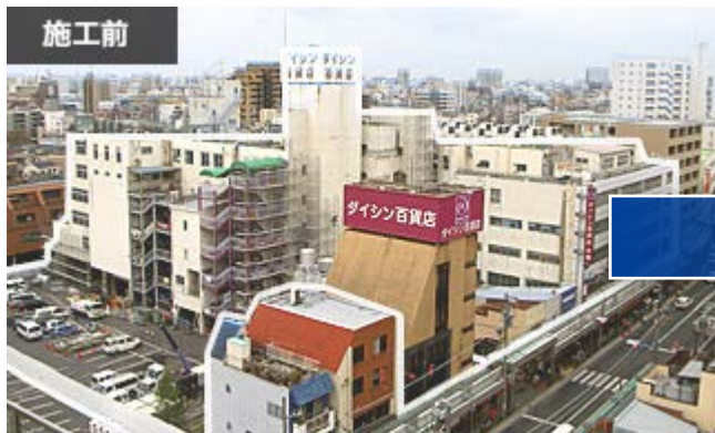
第一期建て替え工事①
