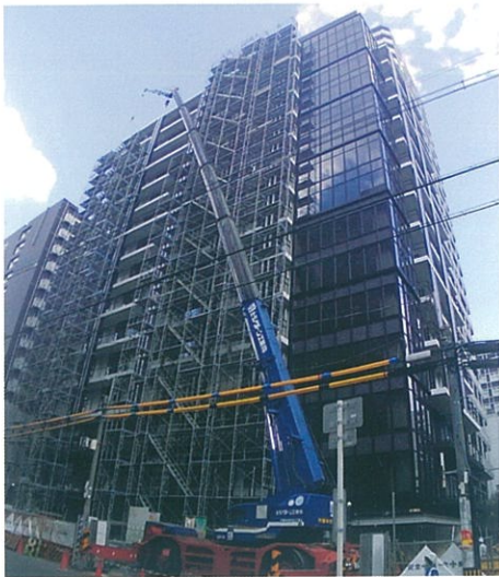
工事状況 (写真提供: イチケン)
