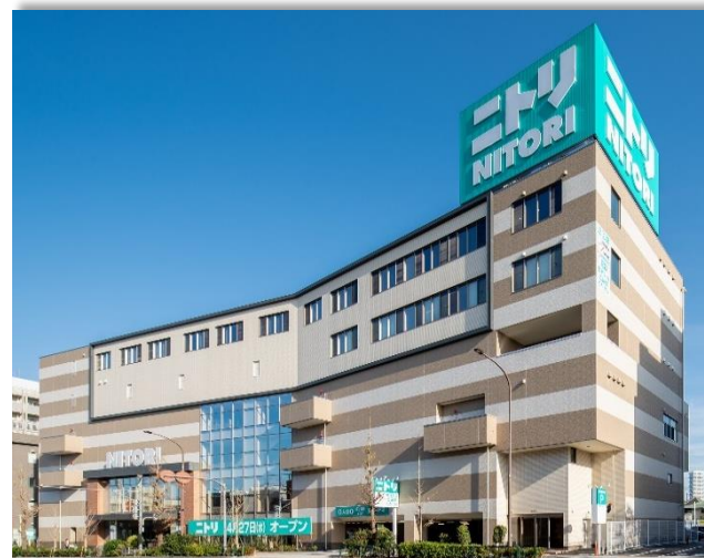
ニトリ目黒店新築工事
