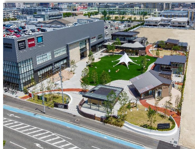
SG(スポーツガーデン)千早建替工事
