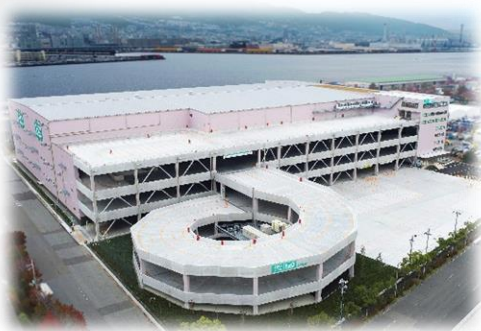
～ニトリ神戸DC～ 求められる建築ニーズ の変化に柔軟に対応。 大型施設建築ノウハウ の蓄積にも繋がって います。
