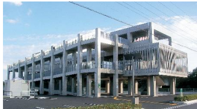
長南中学校校舎等改築工事 (屋内運動場棟)
