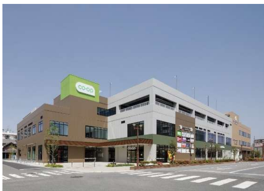
コープかすかベテラス(ZEB Ready)
