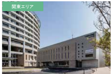
関東エリア 君津中央病院アメニティ棟 [千葉県]
