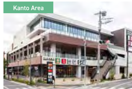
Kanto Area VIERRA Maita [Kanagawa]
