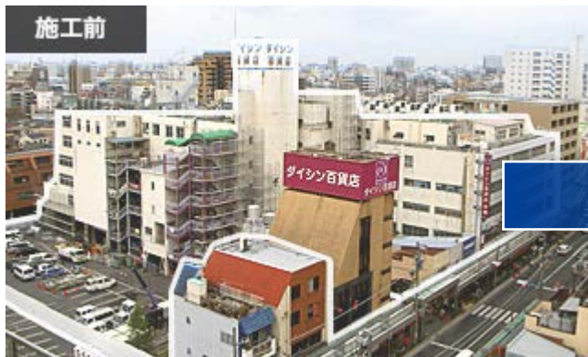
第一期建て替え工事①
