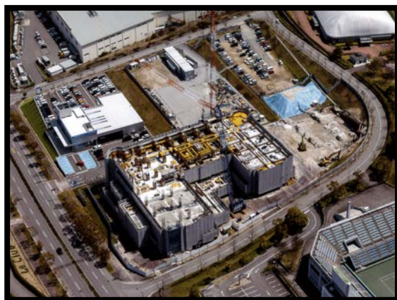
躯体工事 (柱・梁・床・壁)
