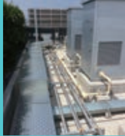
電気や機械設備を組み込む 附帯工事
