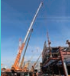
建築物の構造部分をつくる 躯体工事
